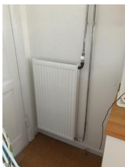
Eksempel på ny installation i bygning C
