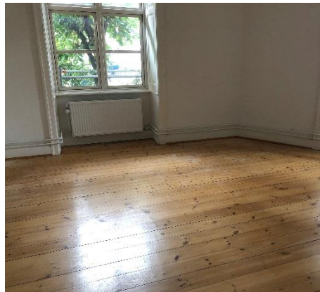
8. radiator og rør-føring i eksisterende boliger.
