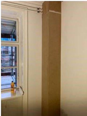
7. rørkasseinddækning af nyt varmesystem med stuk..
