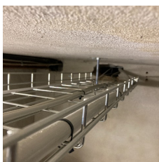
Nr. 5, kælder mod nabo opgang.
