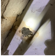
Nr. 9, kælder mod stueetage.
