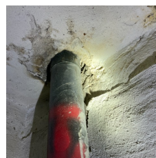
Nr. 7, kælder mod stueetage.
