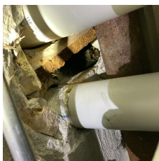
Nr. 7, kælder mod stueetage.
