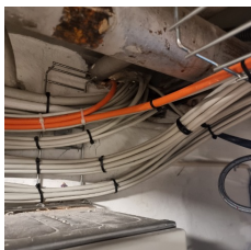
Nr. 10 mellem stueetage og kælderrum.
