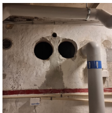
Nr. 12 fra varmecentral mod kælderrum.
