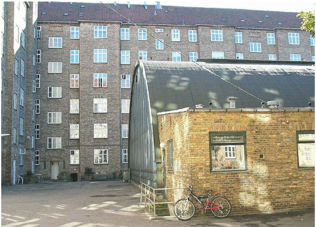
Øst gavl og nord facade
