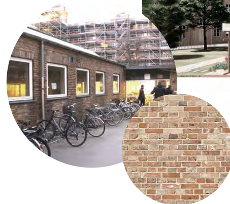
Genbrugstegl fra den nedrevet tilbygning
